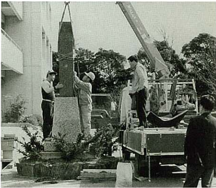
「自琢」の塔を設置する工事
